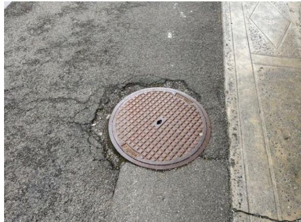
*Belagsschäden im Bereich von Schächten haben direkt Einfluss auf die Schachtanlage.*
