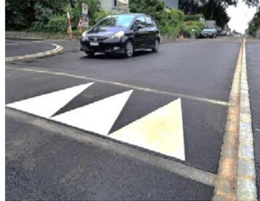
Ein Vertikalversatz ist ein in die Fahrbahn eingebautes «Belagskissen», welches die Verkehrsteilnehmenden dazu bringt, die Fahrgeschwindigkeit den örtlichen Begebenheiten anzupassen.
