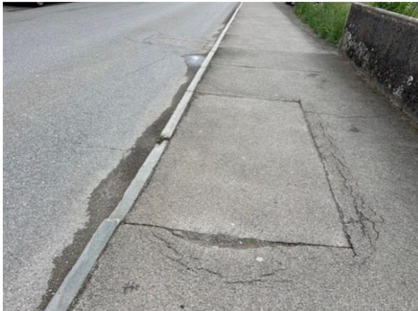
*Nach der Reparatur von Leitungsschäden setzt sich der Belag unterschiedlich.*
