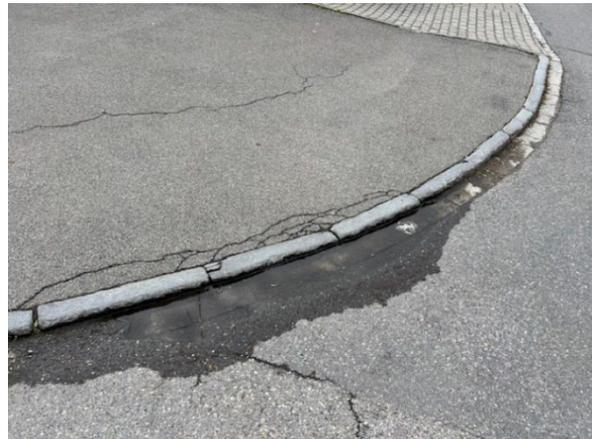
*Defekte Belagsteile und Randabschlüsse führen zu Folgeschäden an der Fundamentalschicht.*
