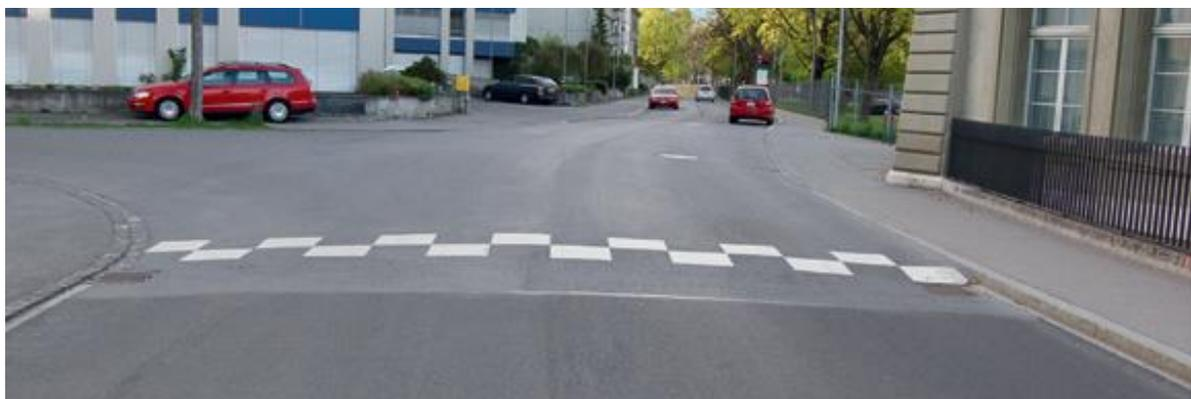
Abb. 23: Beispiel eines Vertikalversatzes
